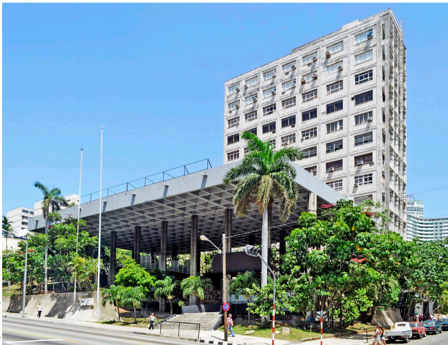
1 y 2 Vestíbulo de acceso y vista general.
