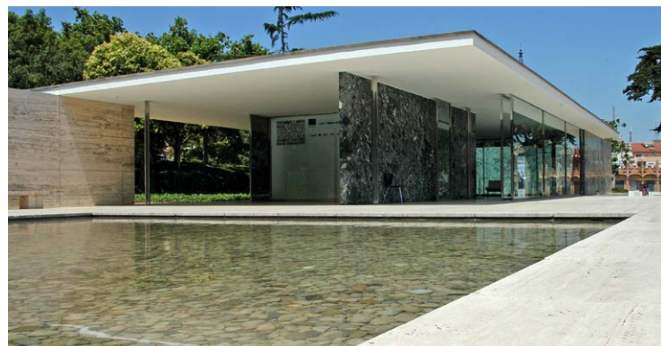
2 Ludwig Mies van der Rohe: Pabellón de Alemania en la Exposición Internacional de Barcelona de 1929, reconstruido en 1986, en su emplazamiento original, por Ignasi Solá-Morales y equipo.
